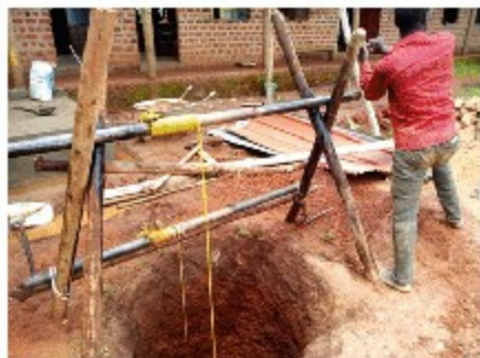
Brunn enbohrung für die Wasserversorgung
