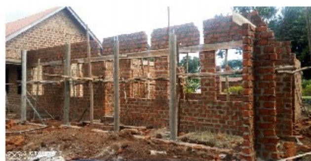
Kindergarten in der Bauphase
